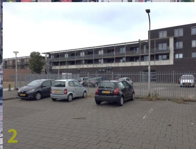
Zicht op afscheiding privé parkeerplaatsen
