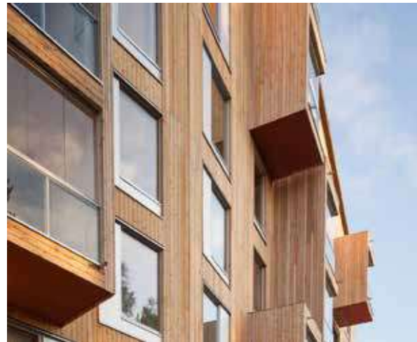
referentie: Houtbouw bij appartementen met geïntegreerde buitenruimten
