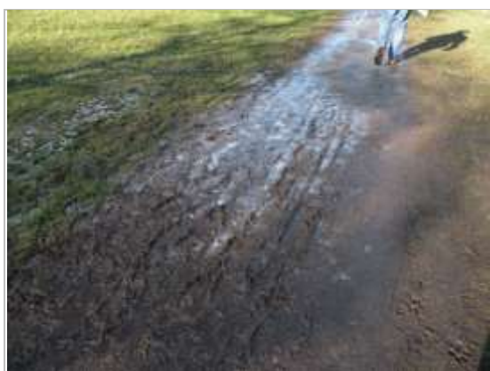
Halfverharde paden degraderen snel als er plassen op blijven staan of als er langdurig bladresten op blijven liggen
