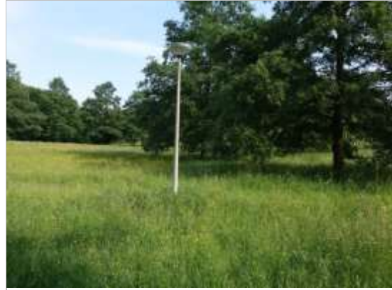
Deze lichtmast staat midden in een veld, waar vroeger pad liep. Overbodige masten verwijderen
