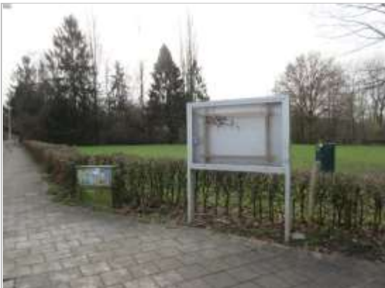
De informatieborden herstellen en aanvullen. Plek voor aankondigingen van de gemeente en/of parkgebruikers, het laatste in overleg met gemeente
