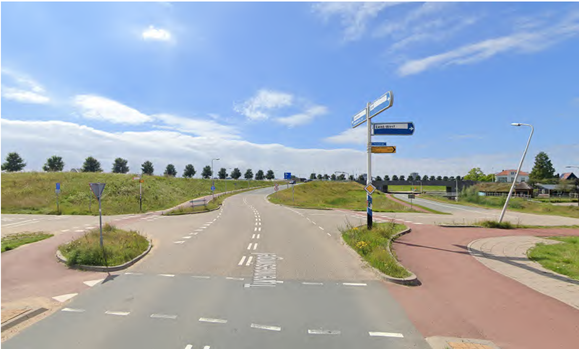
Verbetering oversteekbaarheid door brede middenberm
