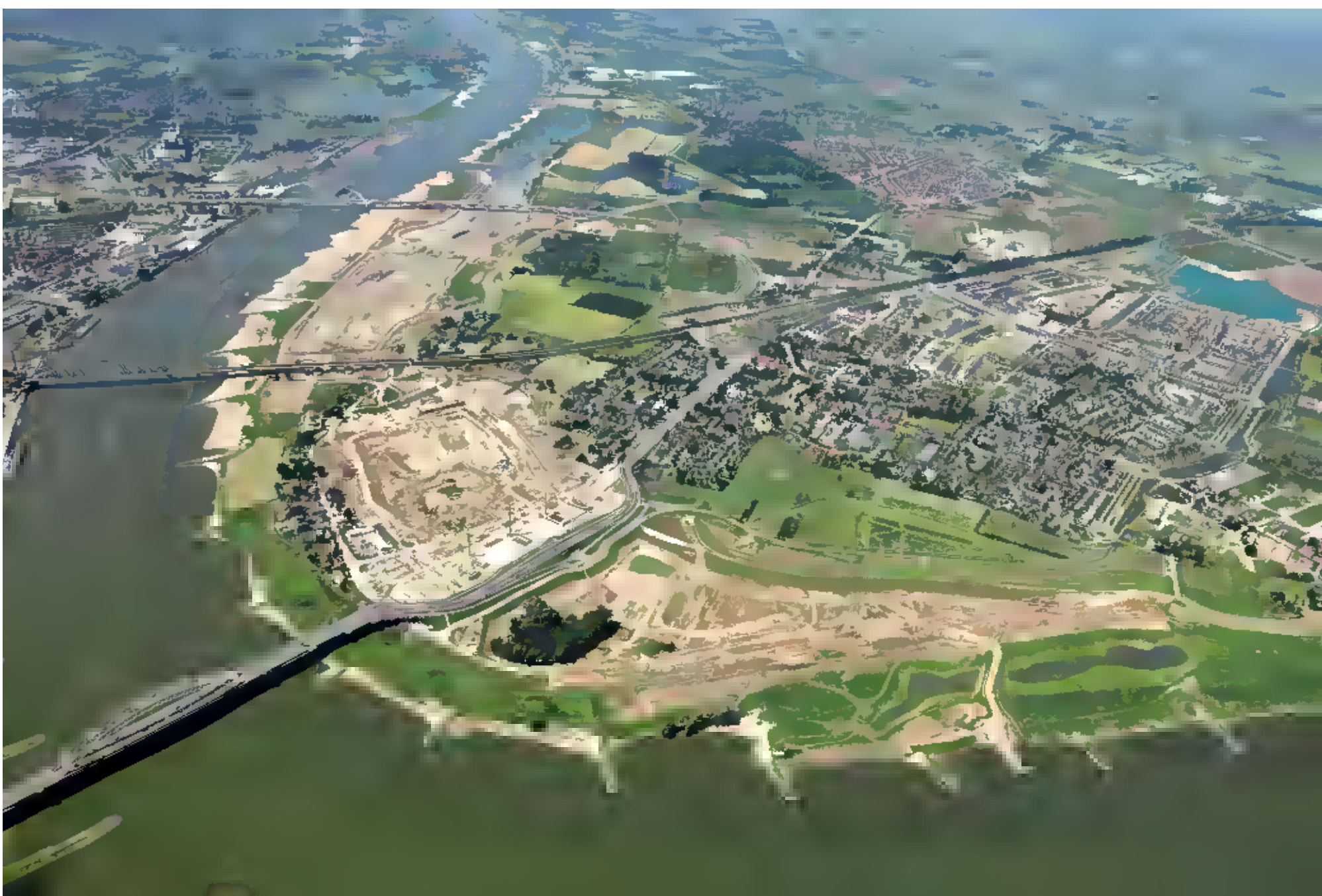
2012 - 2016 ‘Het gebied verandert’ Werkzaamheden Ruimte voor de Waal: Dijkteruglegging
