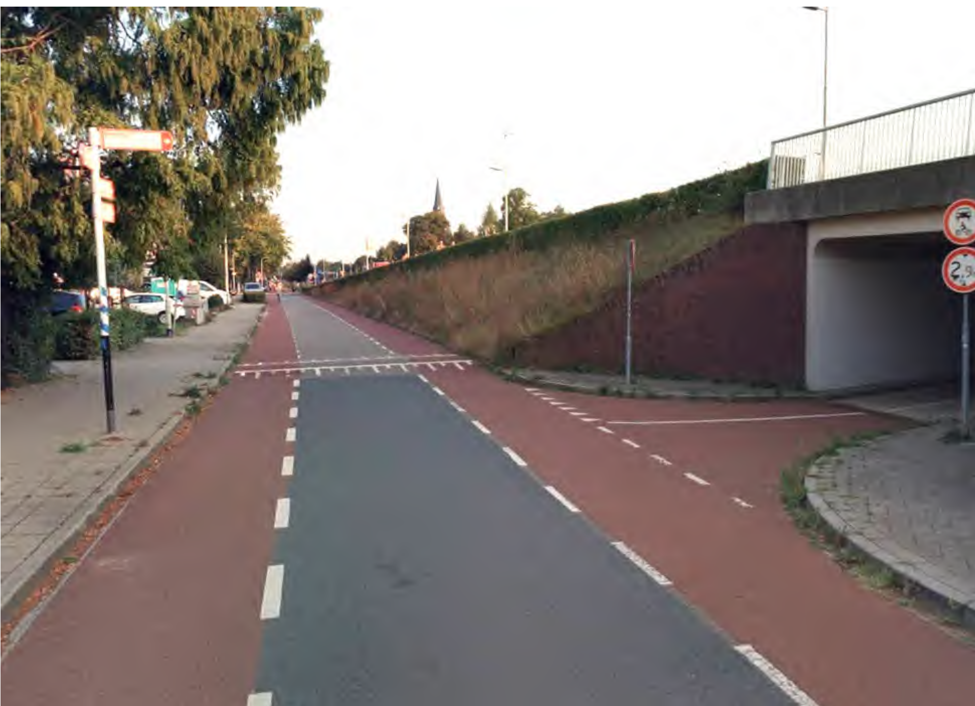
Betere snelheidsremming bij fietstunnel 2 (voorrangsplateau)
