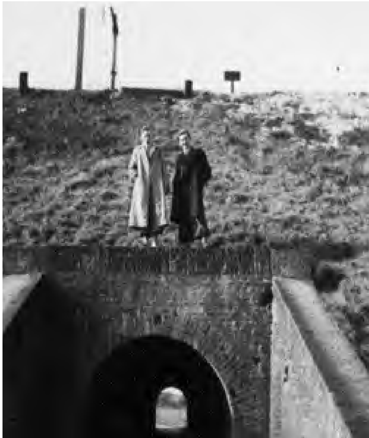
Het spoortunneltje bestond uit een gemetseld tongewelf en was zo'n 30 meter lang, 2 meter breed en 2.70 m hoog. Onder het tunneltje lag een duiker.
