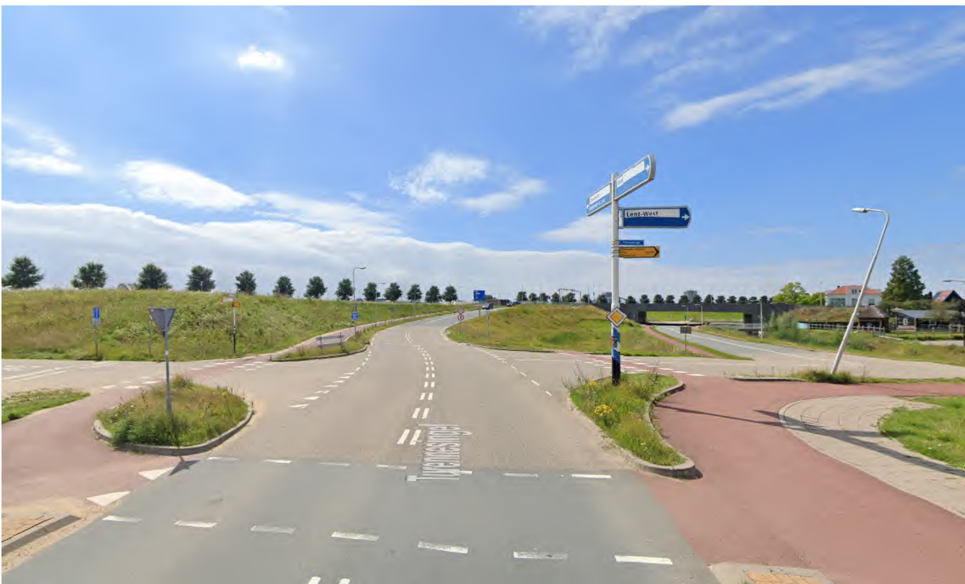
Verbetering oversteekbaarheid door brede middenberm
