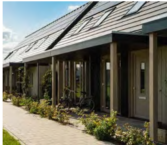
Ref. 3.36 Veranda's aan het park
