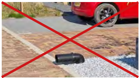
Ref. 3.1 Afwatering via buis niet toegestaan
