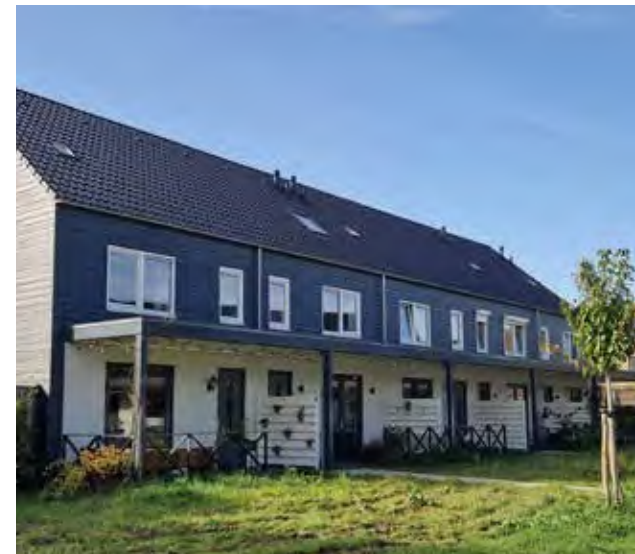
Ref. 3.37 Veranda's aan het park
